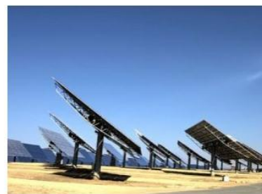
Avanços da Energia Heliotérmica no
